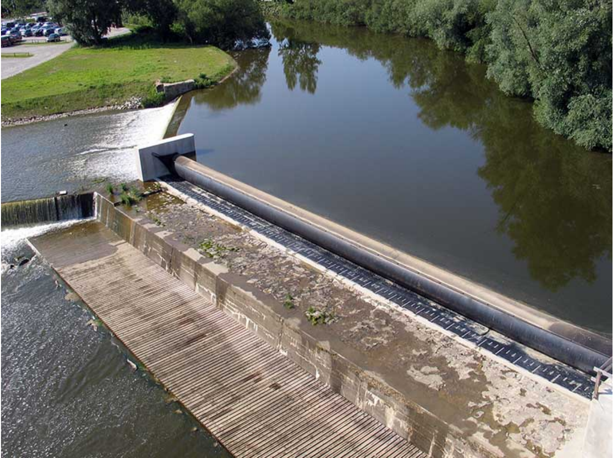
Mit dem Schlauchwehr wird der Hochwasserdurchfluss gesteuert
